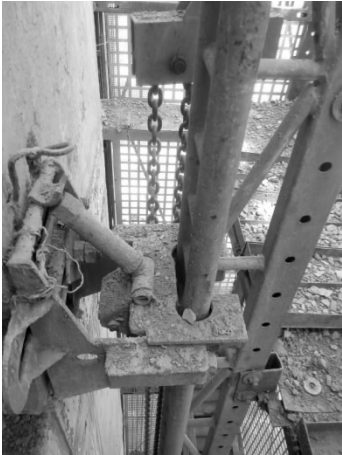
图1 原有固定导座 Fig.1 Original guide bearing
