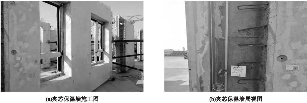
图2 夹芯保温墙实例 Fig. 2 Sandwich insulation wall example
