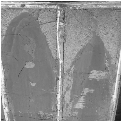
图 12 墙体内部发泡混凝土
