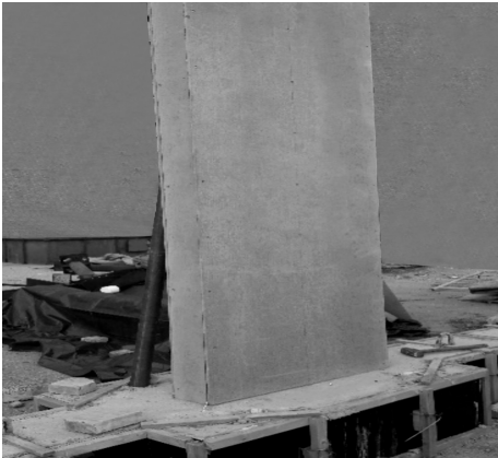
图5 浇注混凝土 Fig.5 Pouring foamed concrete
