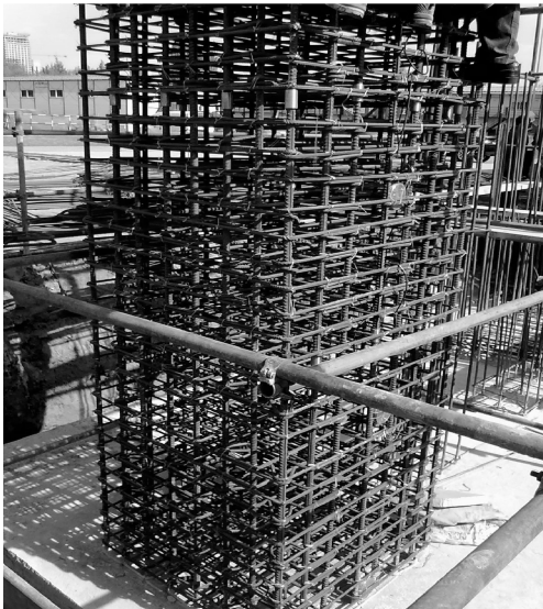
图 2 现场柱配筋
