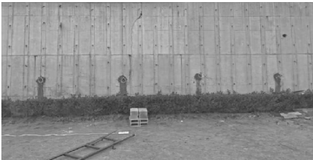
图 11 挡土墙锚杆支护
