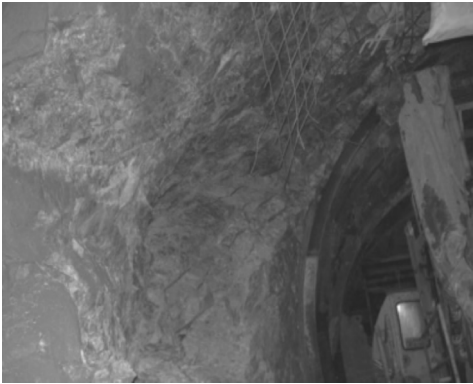
(a) 隧洞南侧壁实际岩爆位置
