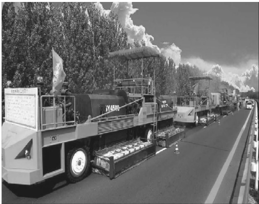
图1 就地热再生技术的施工现场及设备 Fig.1 Construction site and equipment of HIR 就地热再生技术后评估的最主要的部分
