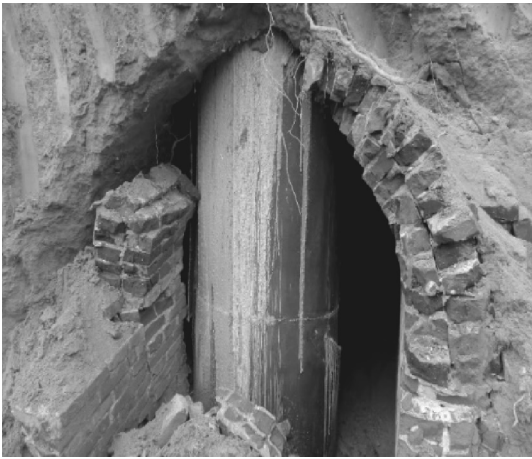
图4 钢护筒混凝土支护桩
